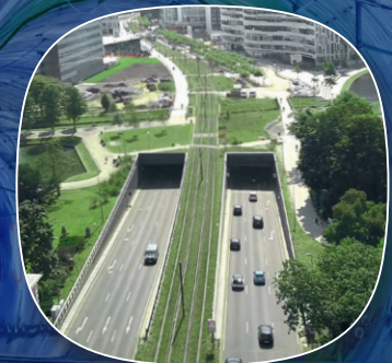
Bauüberwachung Neubau Kö-Bogen-Tunnel
