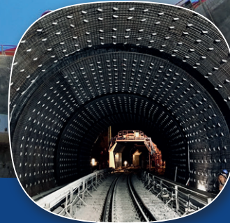
Bauwirtschaftliche Beratung Erneuerung Kuckuckslay-Tunnel
