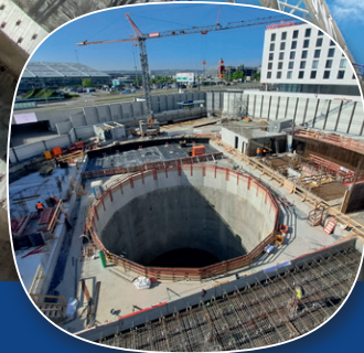
Bauüberwachung Stuttgart 21, PFA 1.3 a – Flughafen- anbindung – Zentraler Zugang Flughafenstation
