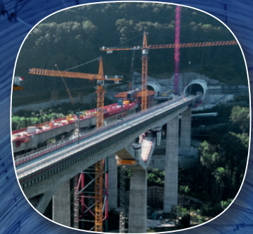
Bauüberwachung NBS Wendlingen-Ulm, PA 2.2, Alaufstieg, Boßlertunnel
