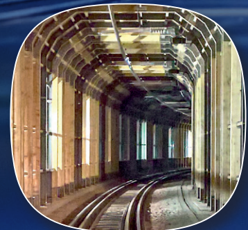
Planung Erneuerung Petersbergtunnel, TiT-Methode unter elektrifiziertem Betrieb
