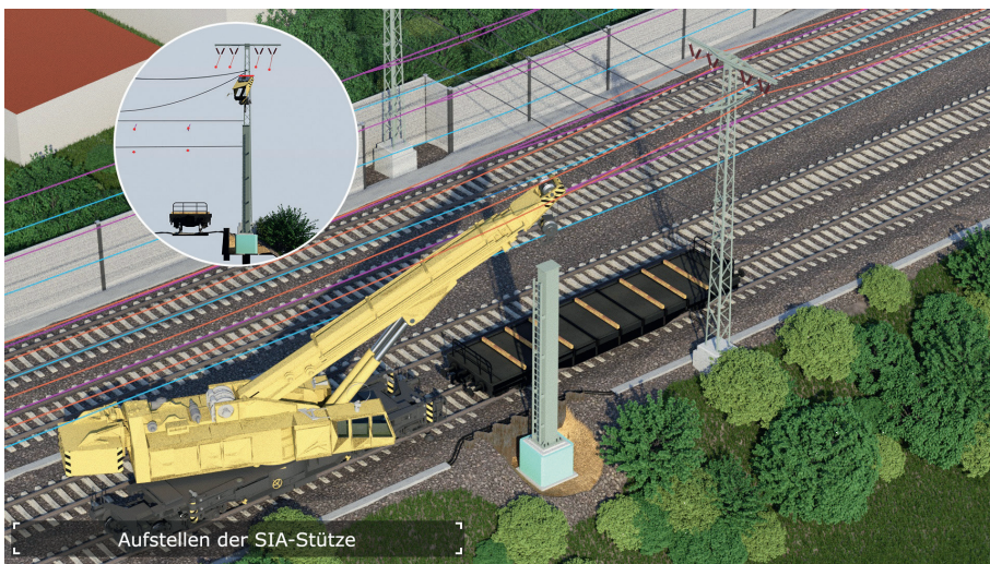
Abb. 5: Montage der SIA-Stütze mittels Eisenbahndrehkran (EdK) in km 2,560 der Strecke 2630 am Kölner Eisenbahnring Quelle: Vössing Ingenieurgesellschaft mbH
