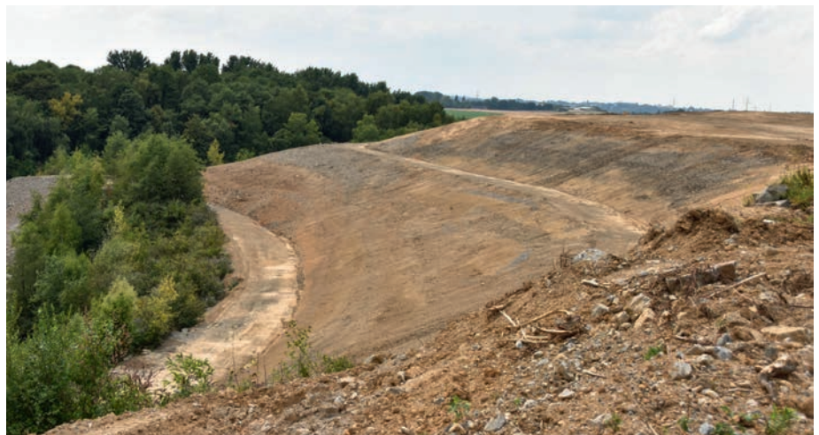
Abb. 7: Deponiebau auf der Halde Hahnenfurth
