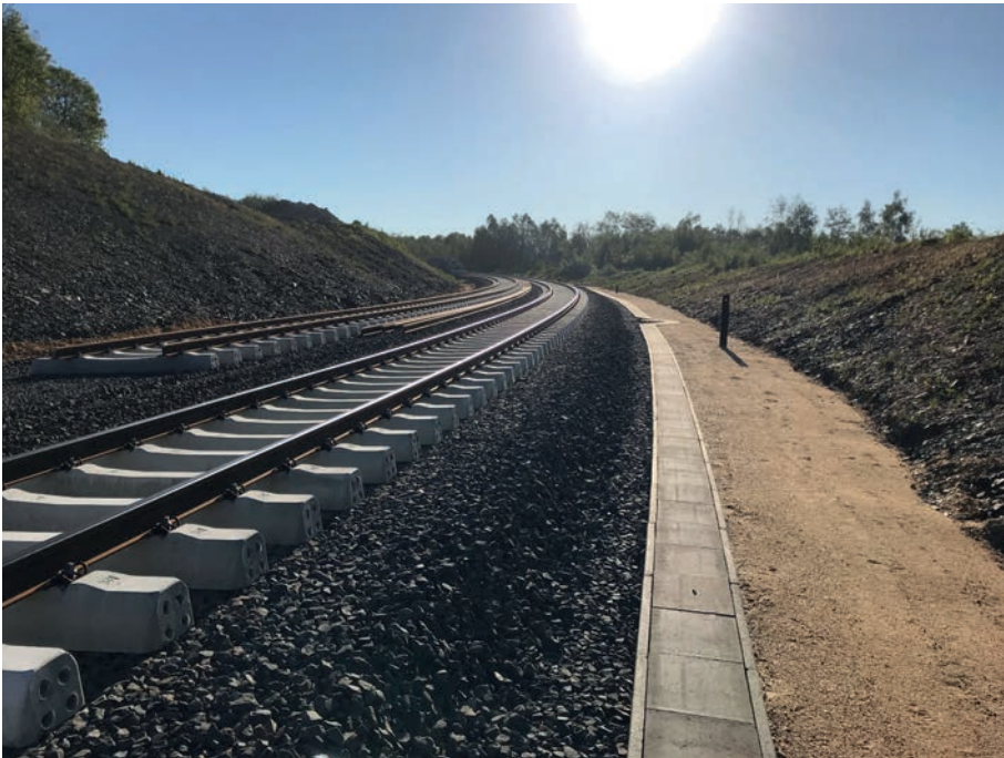
Abb. 8: Baufortschritt Neubaustrecke, bahnrechts der durchgängige Kabelkanal Gr. IIIa
