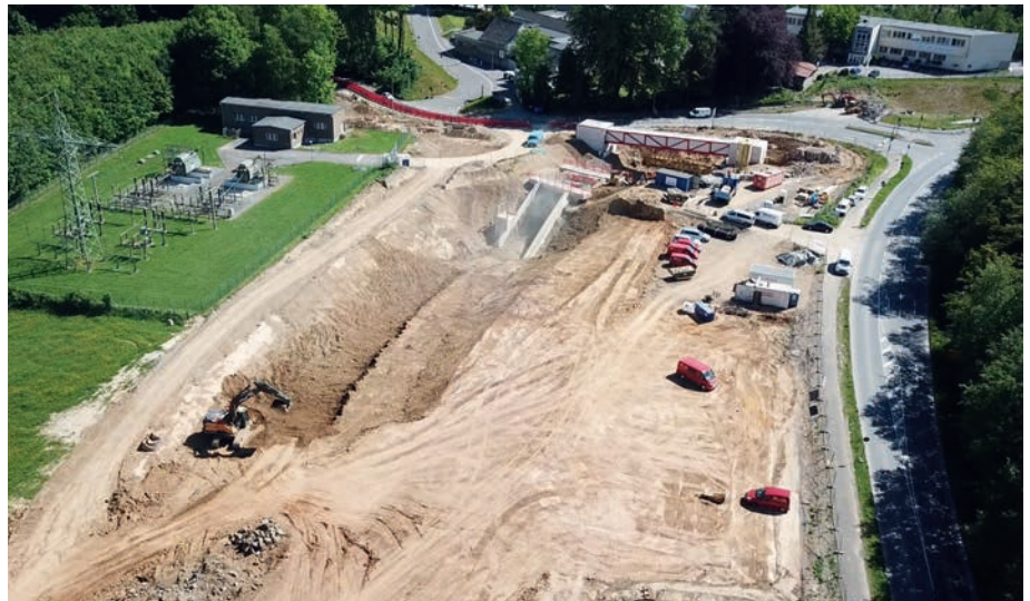
Abb. 6: Drohnenüberflug Verlegung Knoten B7/L422, im Hintergrund die verlegte Büroparkzufahrt
